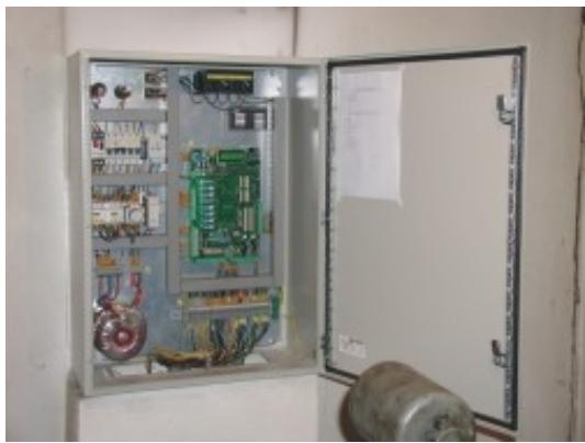
Výťahový rozvádzač PDD16 predstavuje ďalší rozvádzač z certifikovanej produktovej rady ELEVEX1 fy. PANAKO Elevators, s.r.o. Tento rozvádzač je určený ako dvojrýchlosný rozvádzač s pamäťovým riadením, potvrdením volieb a zberom smerom dole pre trakčné lanové pohony. Rozvádzač je možné použiť ako pri rekonštrukciách tak aj novostavbách. Rozvádzač okrem vysokej spoľahlivosti poskytuje užívateľovi napríklad elektrický
